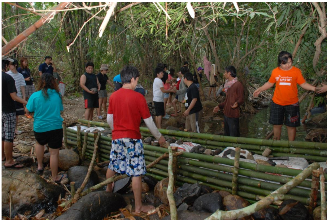
ร่วมมือร่วมใจในการสร้างฝาย โดยนำหินมาวางเพื่อให้ฝายแข็งแรงยิ่งขึ้น
